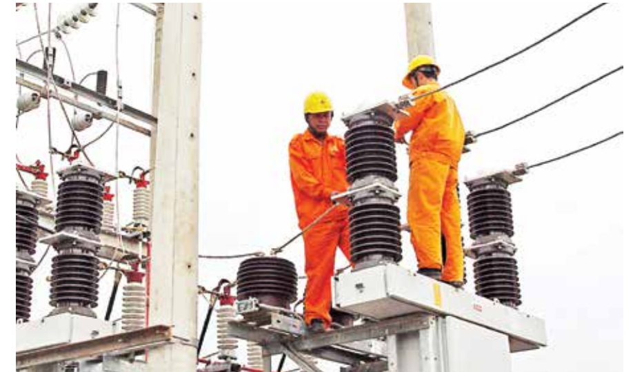
Kiểm tra trạm biến thế đảm bảo an toàn.
