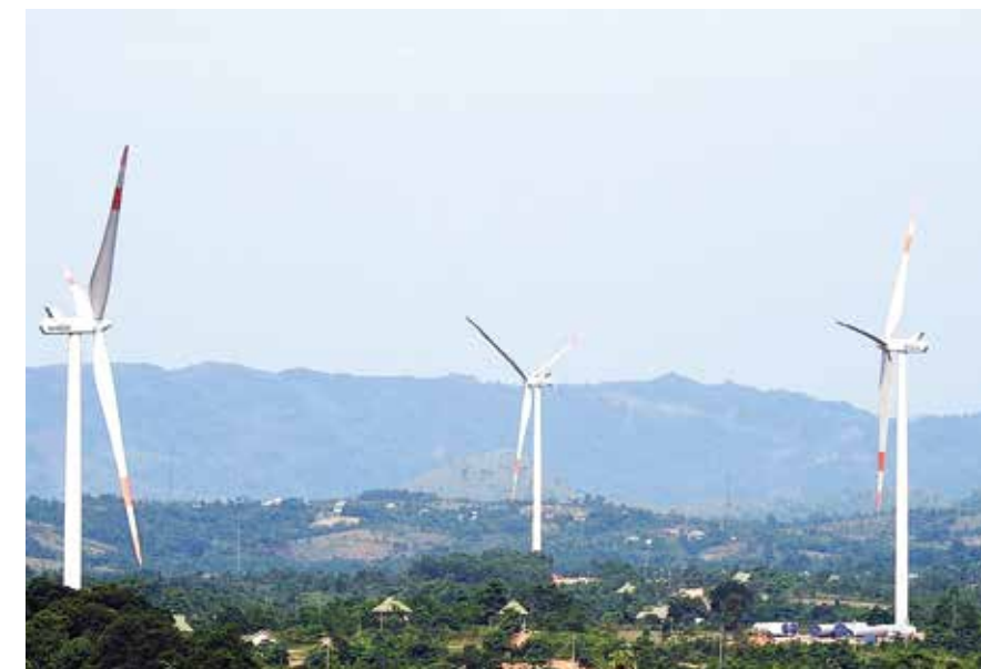
Nhà máy Điện gió Hướng Linh, Quảng Trị.
