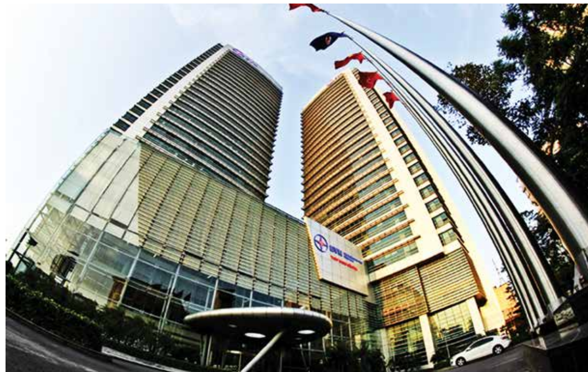
Dự án điện mặt trời giúp tòa nhà EVN tiết kiệm nguồn năng lượng đáng kể.
