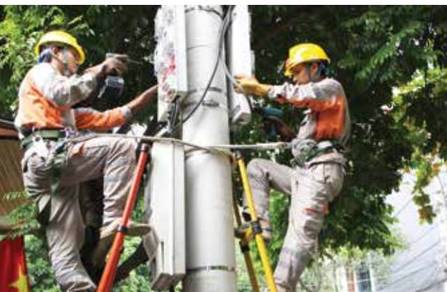
Công nhân Điện lực Thành phố Lào Cai triển khai lắp đặt công tơ điện tử nhằm công khai, minh bạch và ghi chi số công tơ một cách chuẩn xác.
