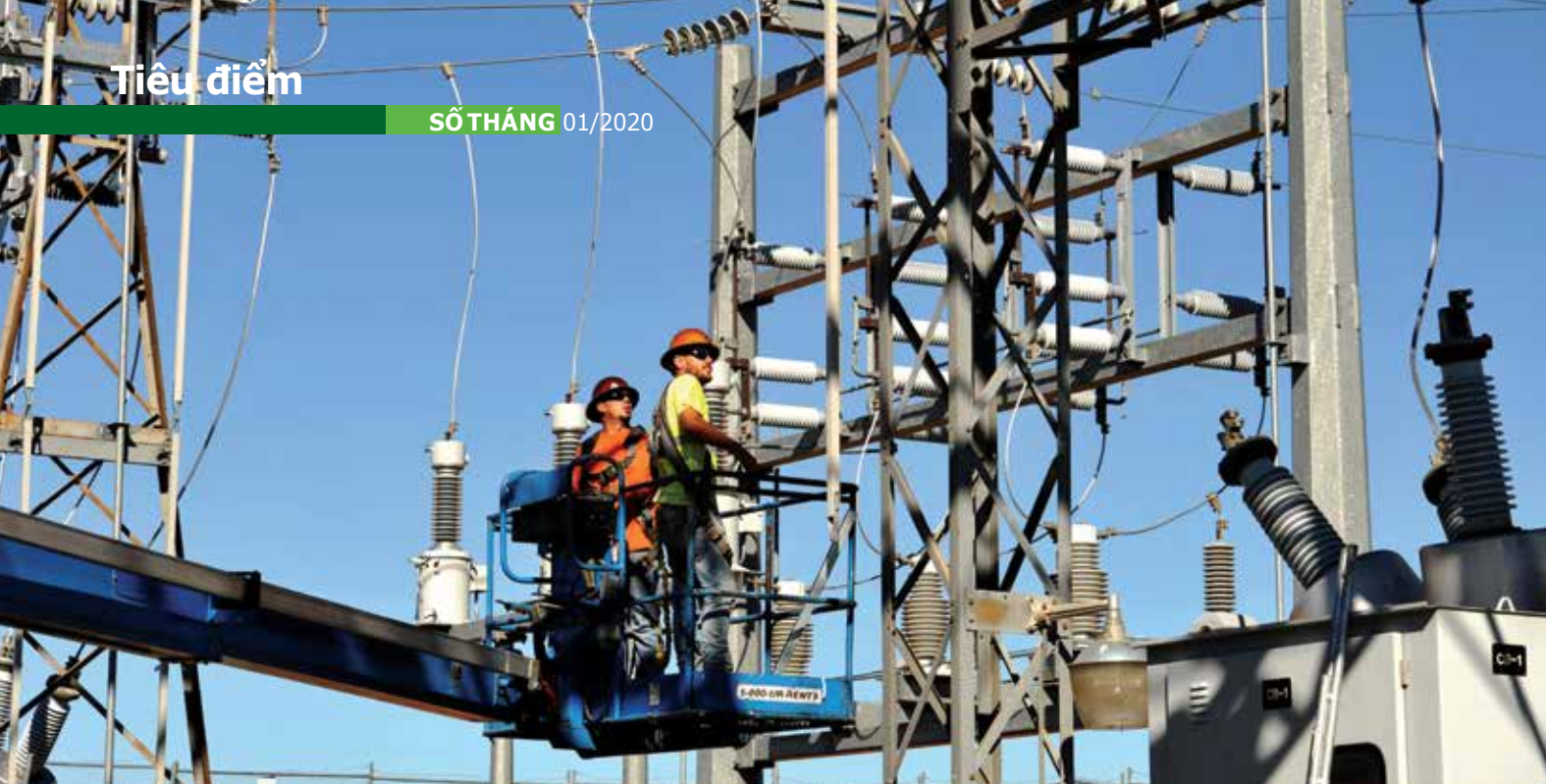
Lưới điện thông minh giúp tối ưu hóa công tác quản lý, chi phí vận hành lưới điện; đa dạng các nguồn phát điện; nâng cao hiệu quả sử dụng điện...
